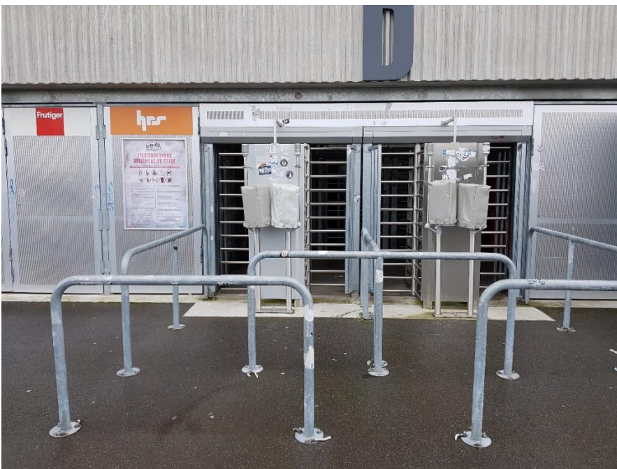
Abbildung 10: Blick auf den Einlassbereich im Gästesektor der Stockhorn Arena.
